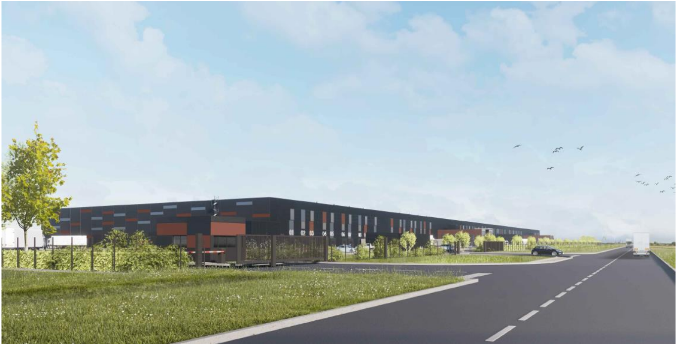
Figure 19 : Vue à hauteur d'homme du site
